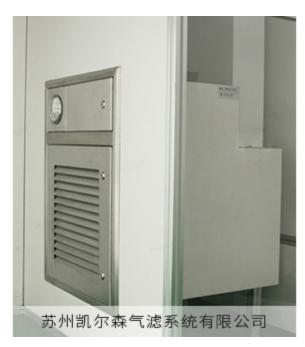
在生物安全实验室中,高效排风口也被称为风口式排风高效过滤装置。高效排风口采用风口式箱体结构,
